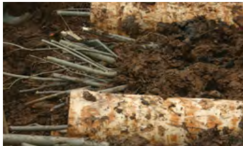
Figura 4.5.5.3 Estacas de salgueiro colocadas nas células do cribwall e cobertas com solo (Fotografia: Antoni Bonafont).
